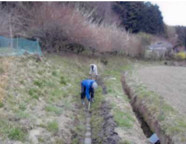
用水路の土砂上げ作業
