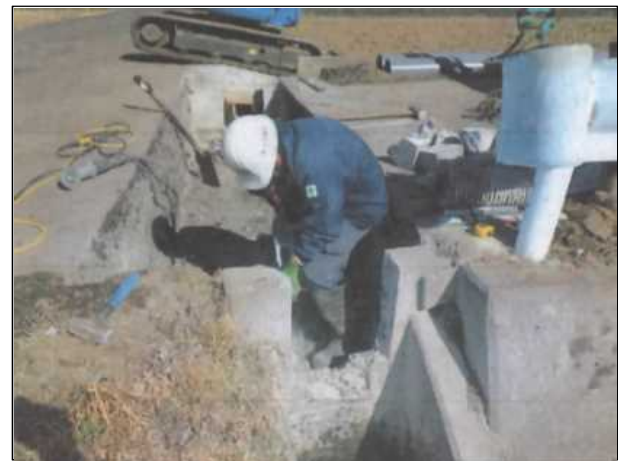
用水路布設替工事
