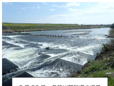
3月29日 久慈川堅磐堰の様子
