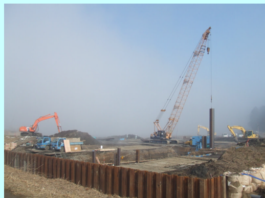
工事の進捗の確認
