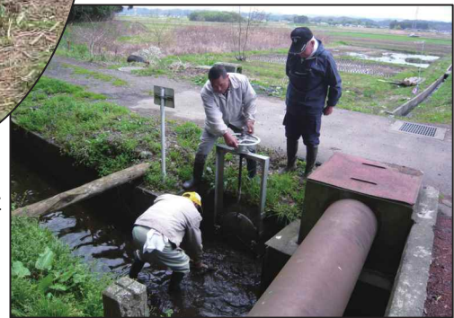
④施設の点検
