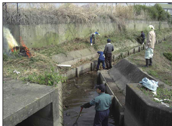
④水路の泥上げ
