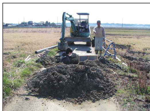
④震災で壊れたパイプラインの補修作業
