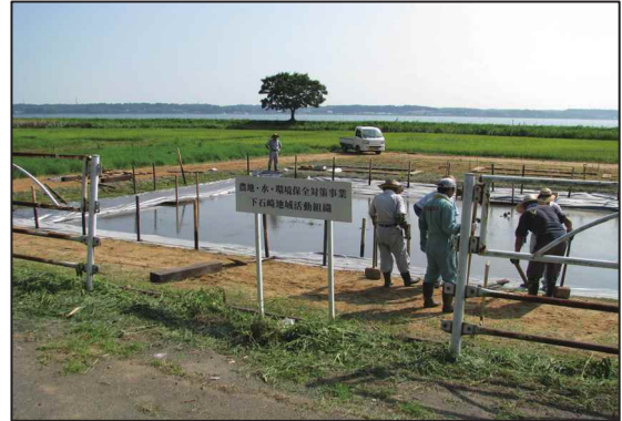
ビオトープ設置
