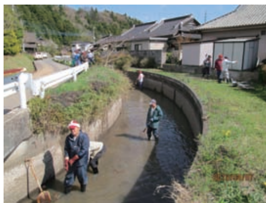
②水路の泥上げ
