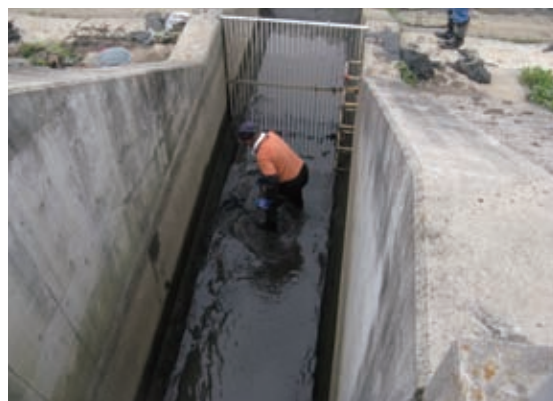
②水路の泥上げ
