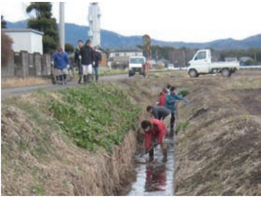
③水路・側溝の泥上げ
