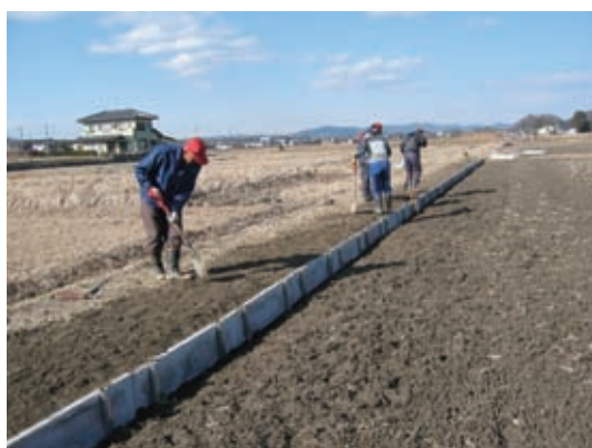
③農道の路肩，法面の補修
