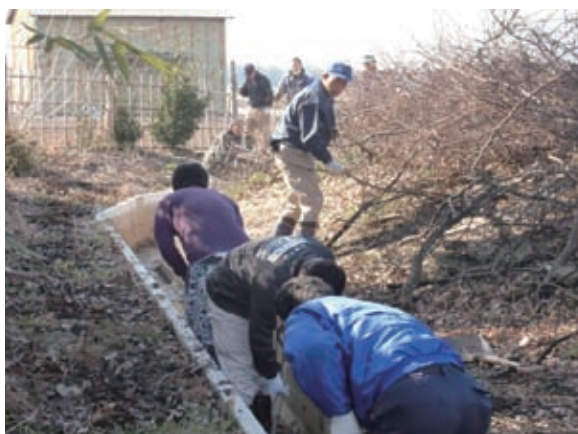
①水路の泥上げ
