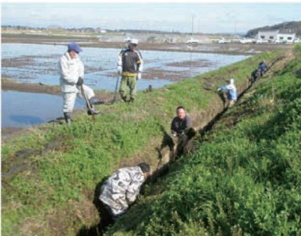
①水路の泥上げ
