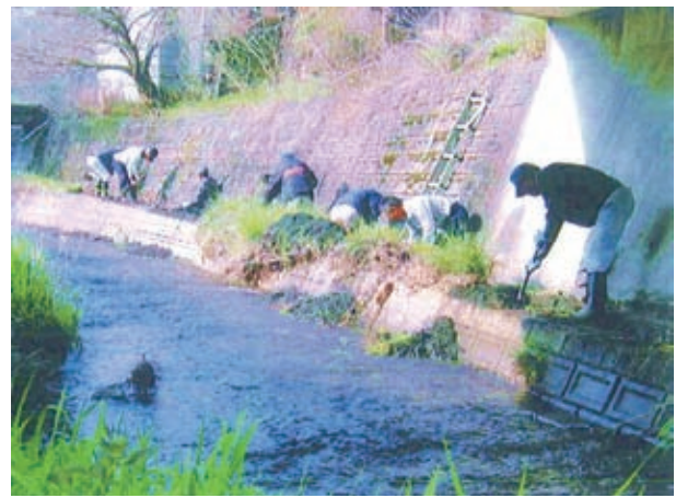
②水路の泥上げ
