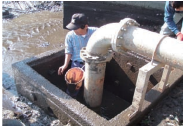
②パイプラインの機能診断・破損箇所の修繕
