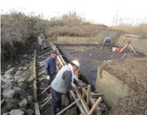
③水門堰の補修
