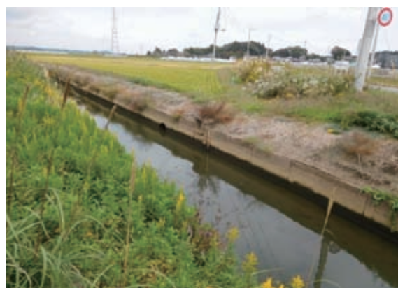
②幹線排水路法面への防草シートの活用
