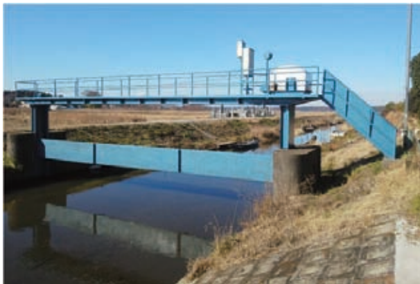
③用水施設の保守管理（防錆材塗布）
