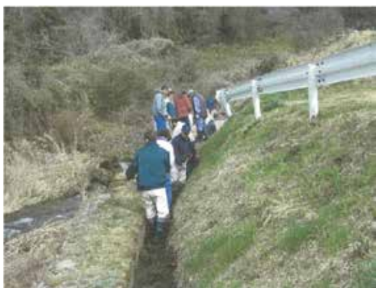
水路の泥上げの実施
