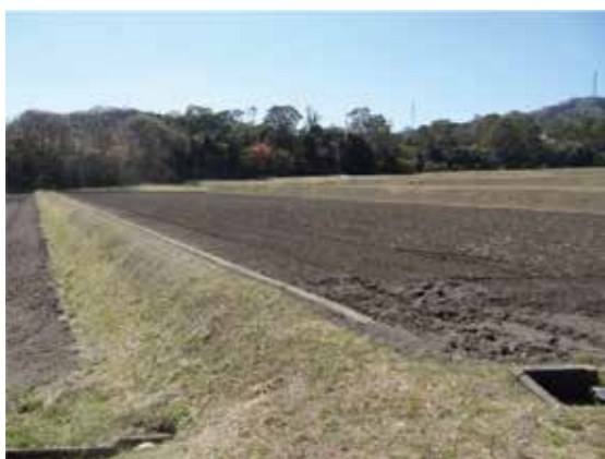
適正に管理された法面
