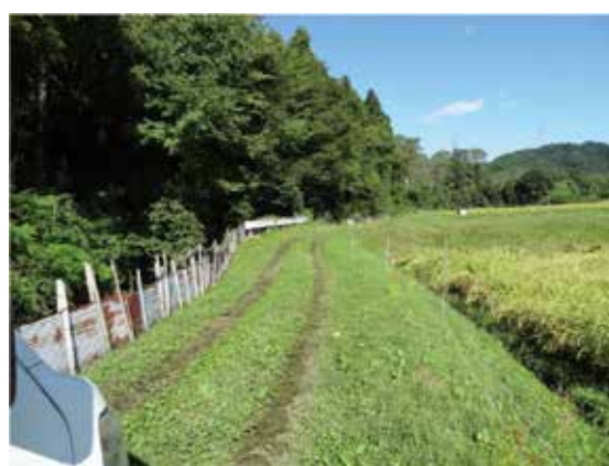
鳥獣防護柵の設置
