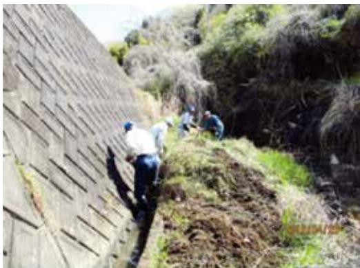
水路の泥上げの実施
