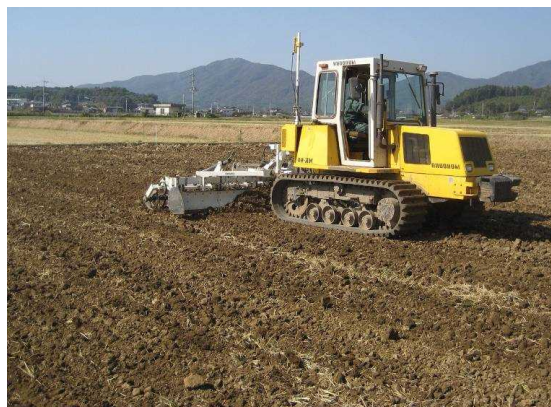
図7. レーザーレベラーを使用した均平および鎮圧作業
