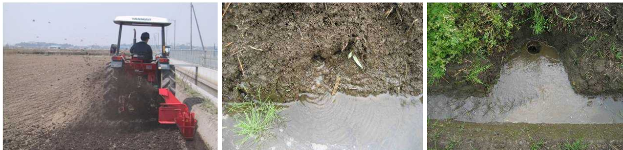
図10. 溝掘機を使用した明渠施工作業（左）、隣接田からの漏水（中）、および明渠による排水状況（右）
