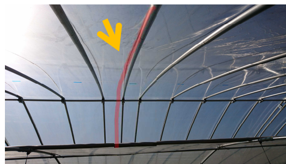
図-37 アーチパイプ増設による強化
