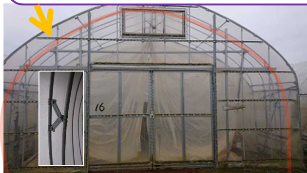
図-35 ダブルアーチパイプで強化 天井高が高くなり換気窓も設置し高温時の環境改善
