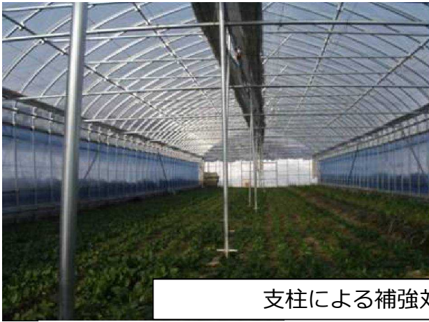
図-4 1 ハウスの雪害対策（福井県雪害対策マニュアル）
