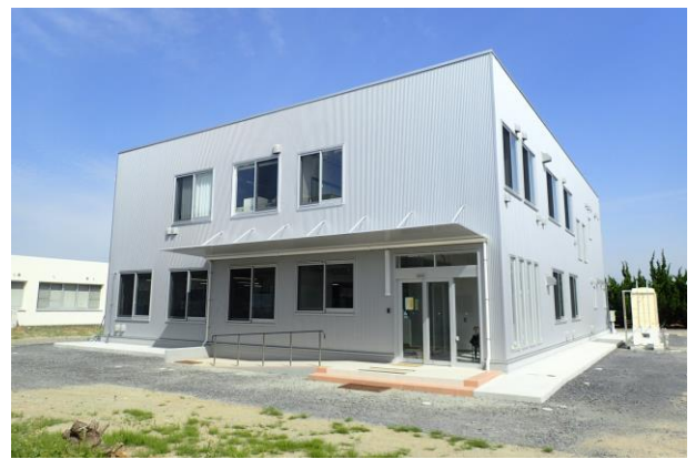
内水面支場 研究棟
