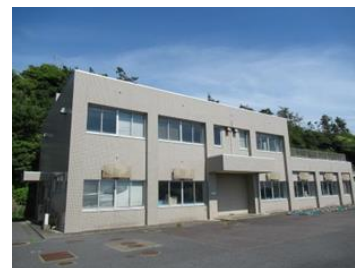
水産加工実験棟
