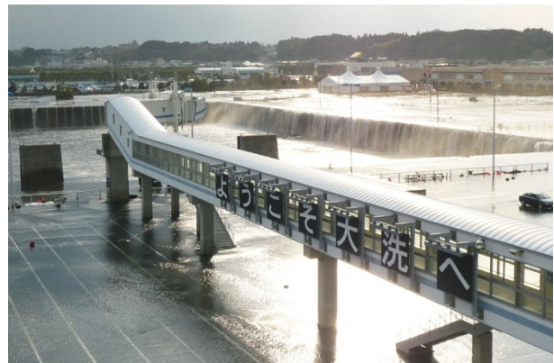
第2波後の引き波の状況（大洗町）
