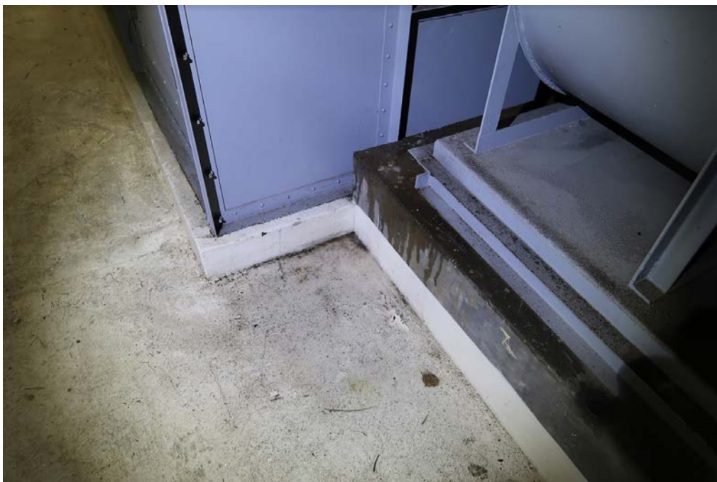
排気機械室床（研究棟屋根開口部の直下）
