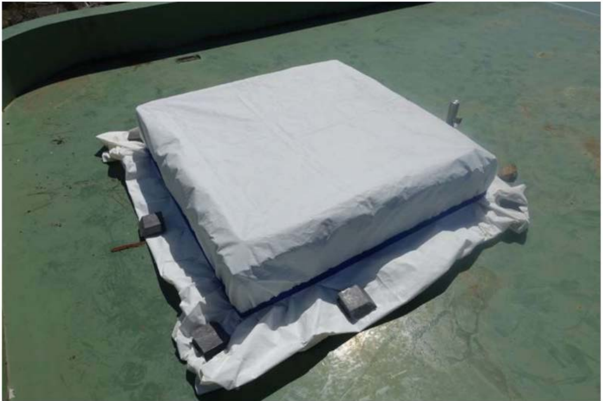
養生（第二段階）後の開口部(4月14日撮影)
