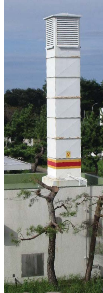
倒壊前の排気筒 (南から撮影)
