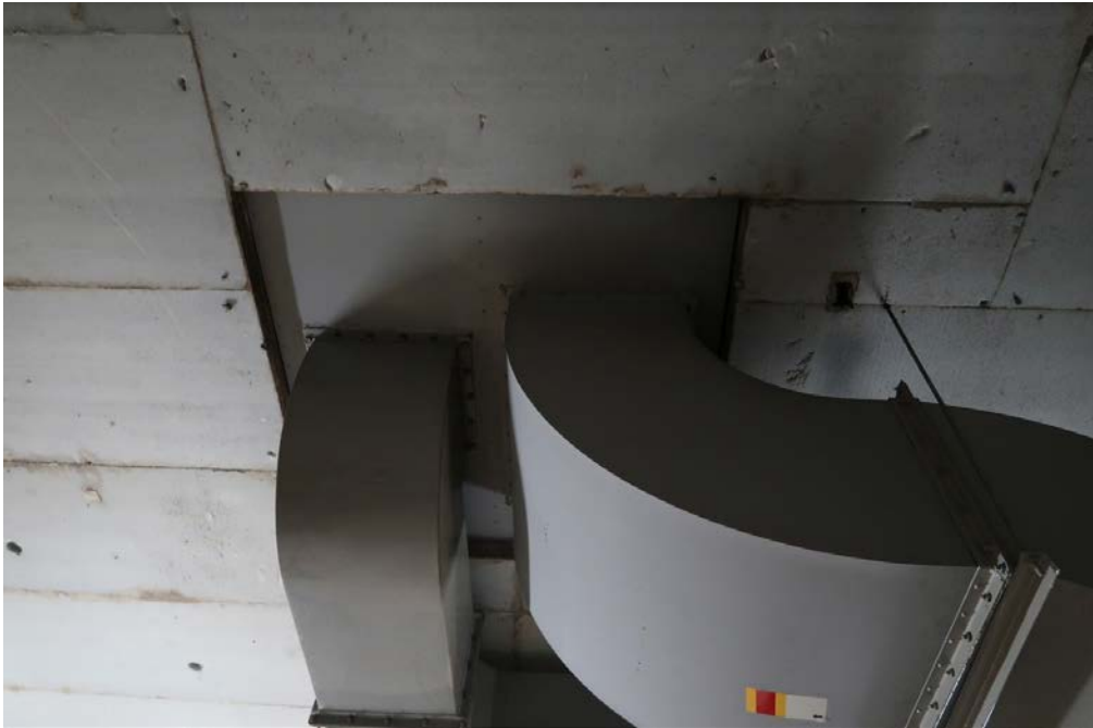
排気機械室天井（研究棟屋根開口部の直下）
