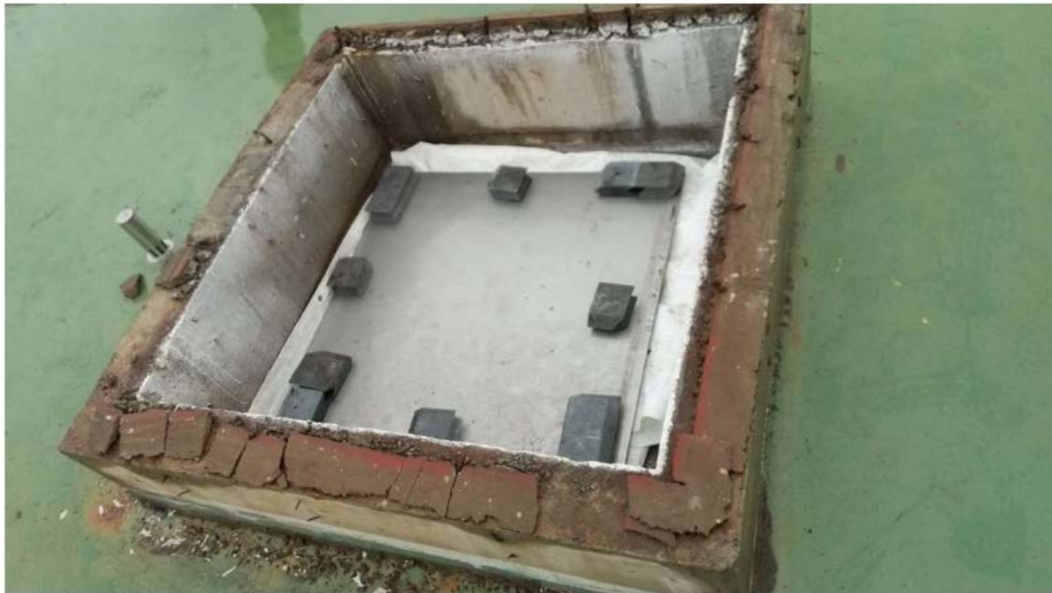
養生（第一段階）後の開口部(4月13日撮影)
