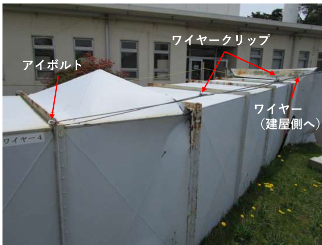
排気筒側：アイボルト、ワイヤークリップ、ワイヤーの位置関係 (ワイヤー1~4：写真はワイヤー4)
