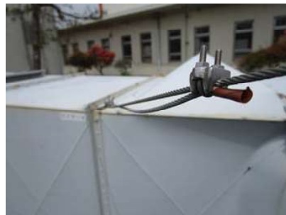
建屋側：アイボルト、ターンバックル、ワイヤークリップ、ワイヤーの位置関係 (ワイヤー1、2：写真はワイヤー2)
