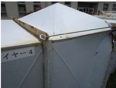
建屋側：アイボルト、ターンバックル、ワイヤークリップ、ワイヤーの位置関係 (ワイヤー1、2：写真はワイヤー2)
