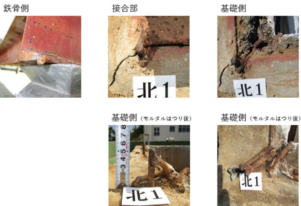
図10 北1の写真 (“接合部”は、接合した状態を再現して撮影したもの)
