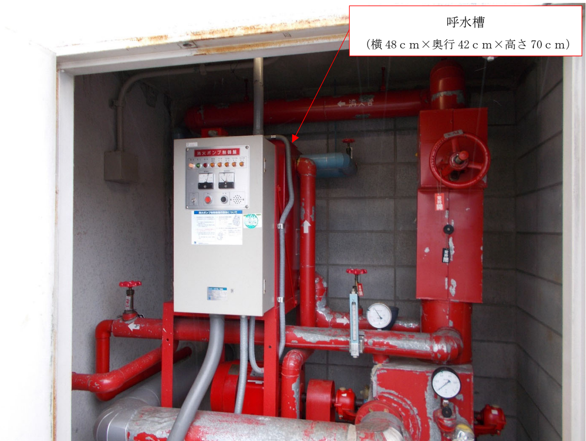
写真2 消火栓ポンプ室内 (呼水槽は操作盤裏)
