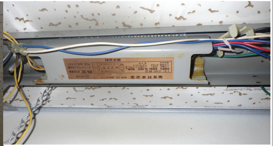
器具反射板を取外した蛍光灯器具
