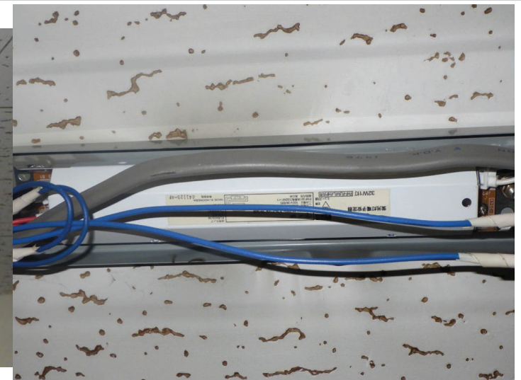
当該蛍光灯器具と同系統の蛍光灯器具 外観に変形及び変色等の異常はなし
