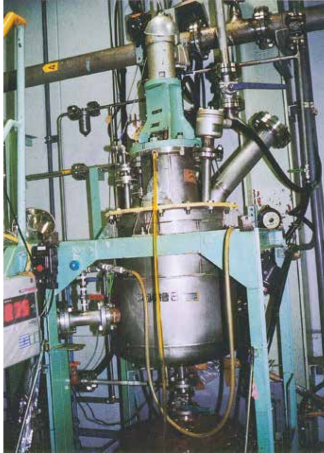
事故が起きた沈殿槽
