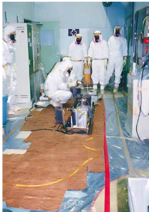
沈殿槽からの溶液抜き取り作業
