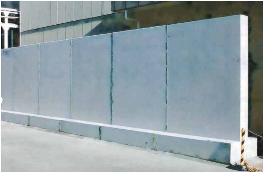
転換試験棟前に設置されたコンクリート壁
