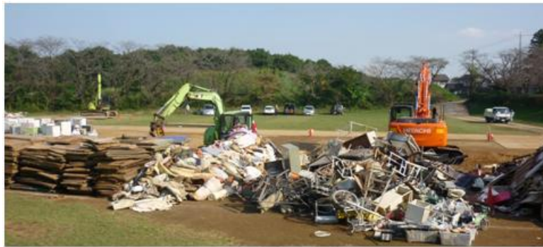
分別が徹底された仮置場(平成 27 年 10 月)
