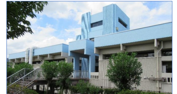
下水処理場における太陽光発電用地の確認
