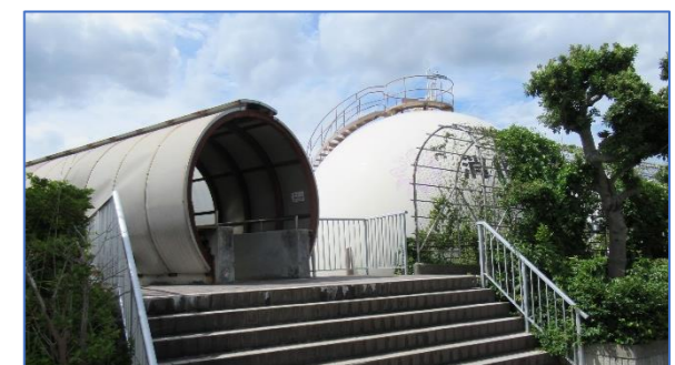
消化ガス発電による再エネ電源の可能性
