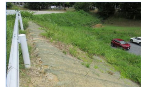
南向き斜面は太陽光パネル設置候補地
