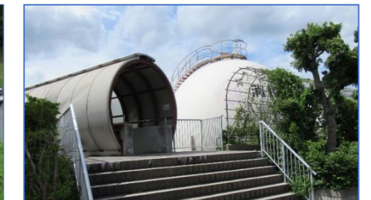
消化ガス発電による再エネ電源の確保
