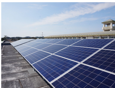
図2.3 屋上陸屋根形（パネルと架台）
