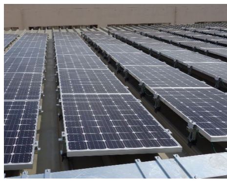
図2.4 折板屋根形（突起物と設置用の金具）
