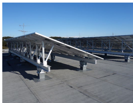
図2.3 屋上陸屋根形（パネルと架台）
