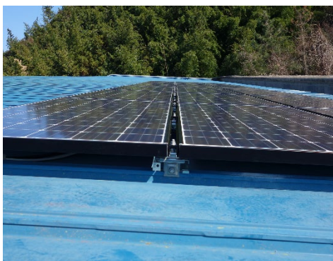
図2.4 折板屋根形（突起物と設置用の金具）
