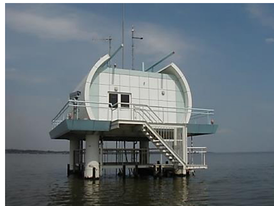
掛馬沖水質水位自動観測所
