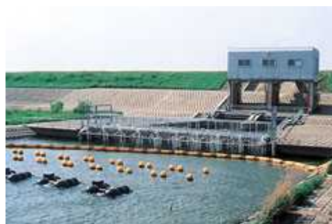
電気スクリーン（利根樋管）
