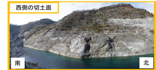
主に粘板岩が分布し、地層の傾斜は東に40° ~45° 程度 ※粘板岩・・・海底に堆積した泥が圧縮・固結されてきた岩
