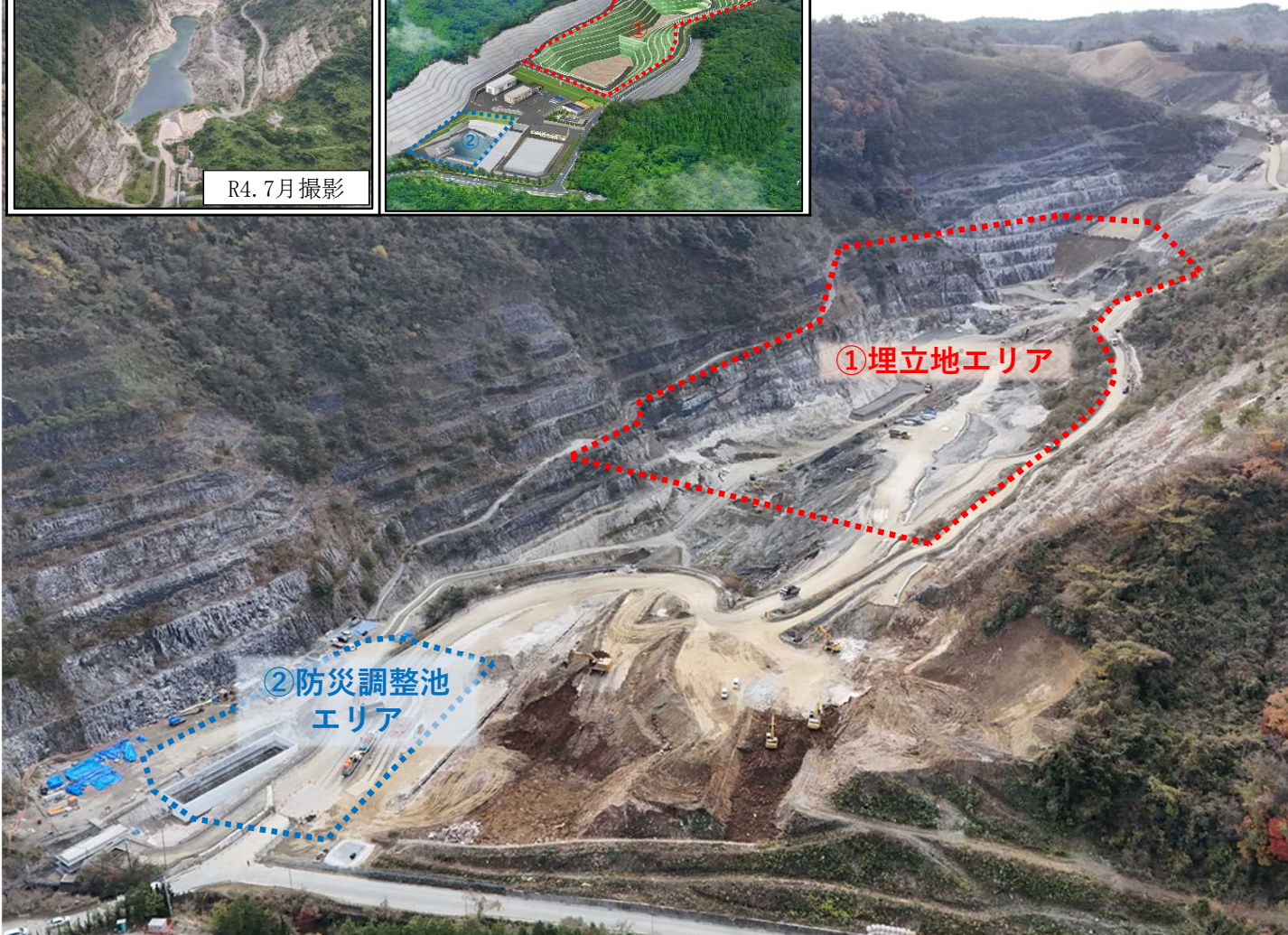
処分場整備地の全体写真 (R6.12月撮影)
