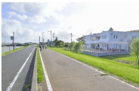
図 7.13 休憩施設 (かすみがうら市交流センター)
