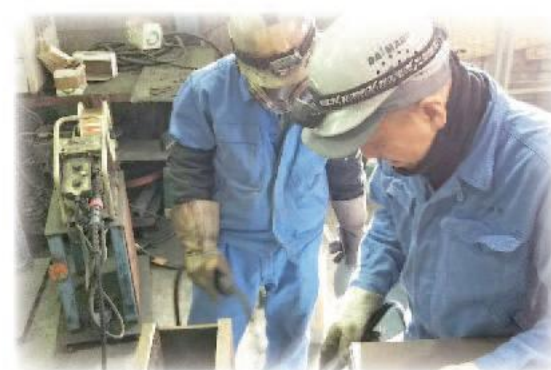
鋼板の溶接作業
