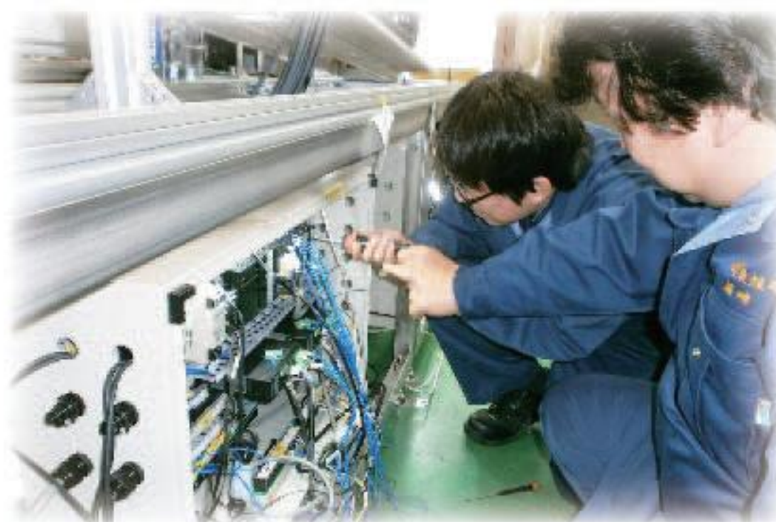
制御盤内の配線作業
