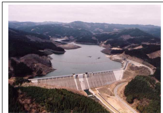
治水のための洪水防御、利水のための用水補給（水道用水・工業用水・農業用水等）など複数の目的を有する多目的ダム
