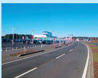
▲アウトレット周辺の県道竜ヶ崎阿見線バイパス
