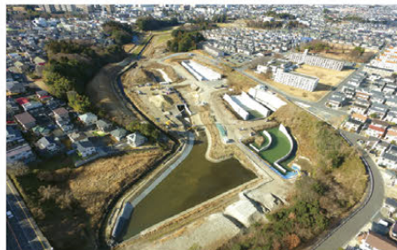
中丸川(調節池整備)
