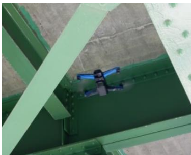
ドローンによる橋梁点検
