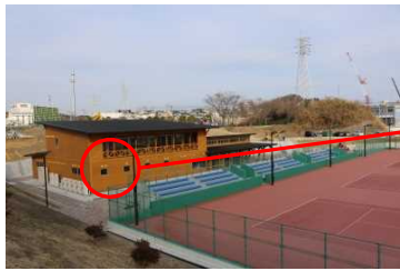
管理棟内への防災施設の整備 (北茨城市磯原地区公園:H30供用)
