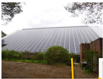
太陽光パネル改修を実施 (洞峰公園:H30完了)
