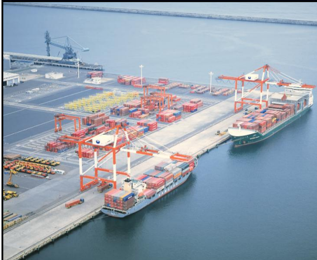
ガントリークレーンによる船積み
