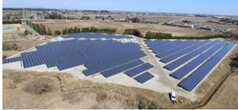
太陽光パネル設置状況
