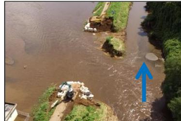
決壊翌日から大型土のうの設置を開始し、9月14日に設置完了
