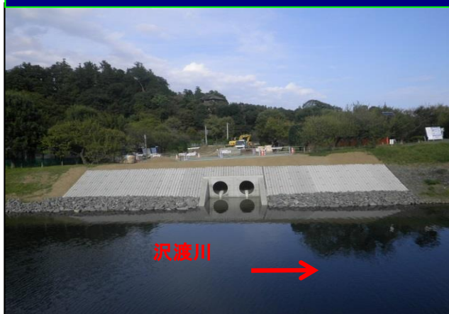
①【県】バイパス水路
