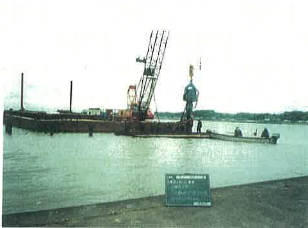
2 H鋼打ち込み
