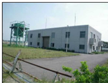
・ 漁港浄化施設
